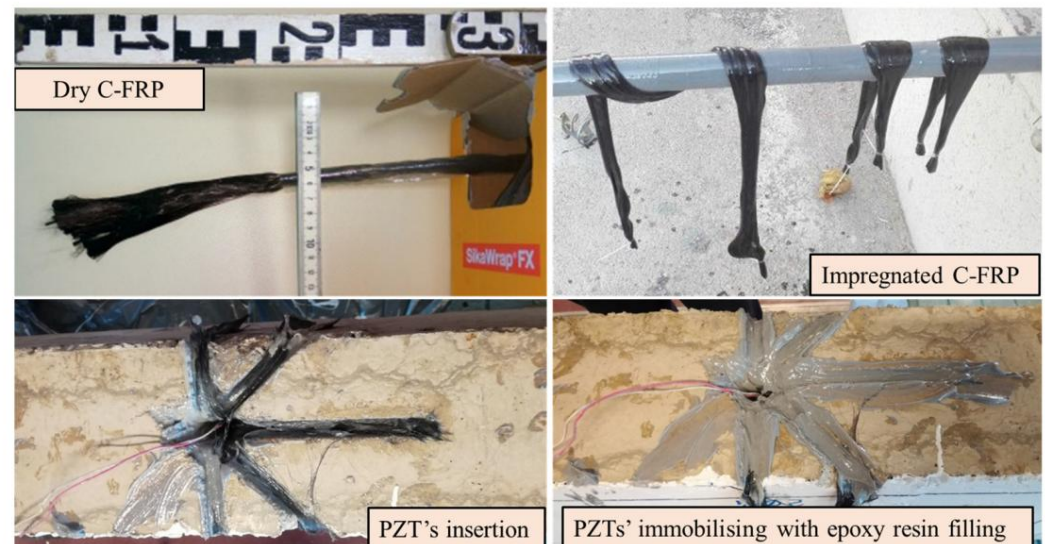
Abbildung 4. Einsetzen der PZT-Wandler in die mittels C-FRP-Seiten montierten Bohrlöcher.
