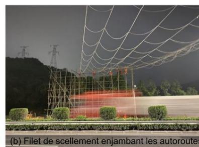
(b) Filet de scellement enjambant les autoroutes
