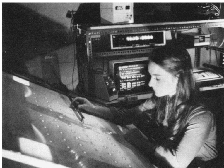
Figure 3.11 Disposition type pour la numérisation par micro-ordinateur des coordonnées de données d'un film cinématographique. La pédale permet à l'opérateur de transférer les données de coordonnées vers l'ordinateur à un rythme d'environ 10 paires de coordonnées par minute. L'erreur de numérisation est d'environ 1 mm rms avec l'appareil photo situé à 4 m du sujet.
