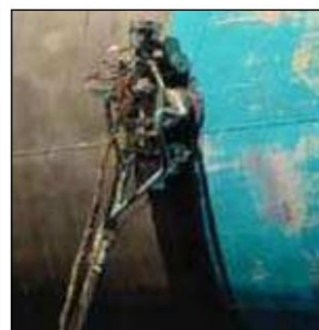
Robot de décapage de peinture EnvirobotTM
