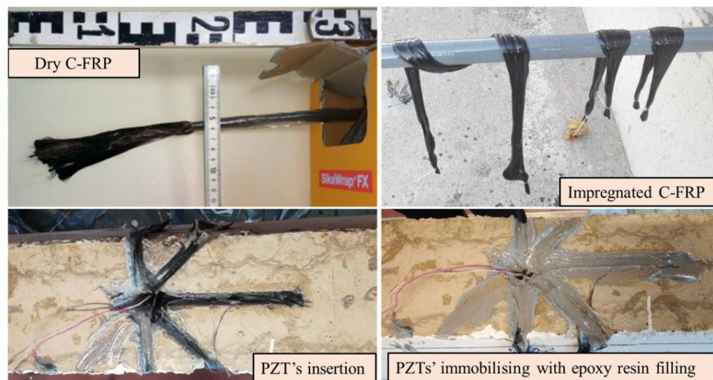
Рисунок 4. Вставка датчиков PZT в просверленные отверстия, собранных с помощью веревки GFRP
